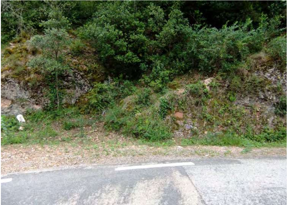
Talús d'obra al revolt del km 16.3 de la carretera. Fet expressament per condicionar l'accés del camí ral.
