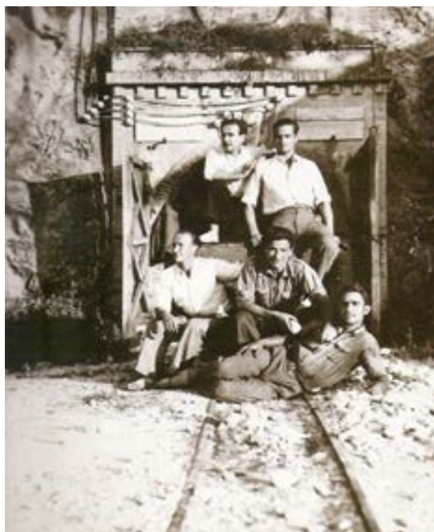
Boca d'entrada a la Mina Berta.
