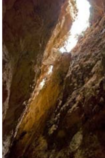
Figura 1: Fragments de roca relativament recents encastats a l'interior de l'esquerda.
